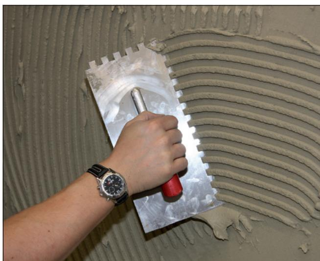
**1** Application de la couche peignée – consistance adaptée pour l'application au mur – sur la couche de contact préparée.
