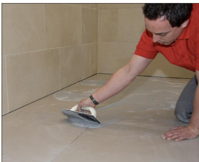
**5** Jointoiment de la surface avec un Joint Sopro (p.ex. Joint Sopro Brillant®).
