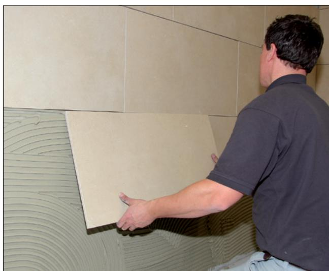
**2** Afficher les carreaux de GPV grand format en exerçant une pression puis ajuster. Avant durcissement, gratter les joints.
