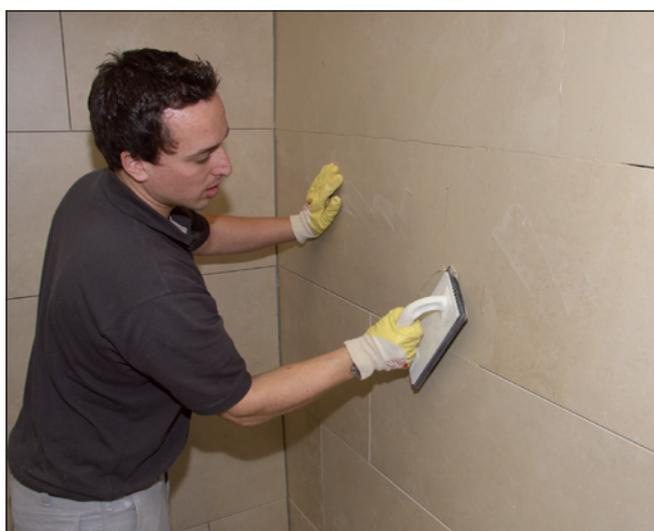
**3** Jointoiement de la surface avec un Joint Sopro (p.ex. Joint Sopro Brillant®).
