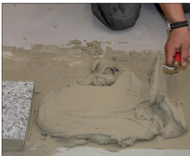
**4** Pour une épaisseur de mortier plus importante, jusqu'à 20 mm, une mise en œuvre à la truelle est également possible.
