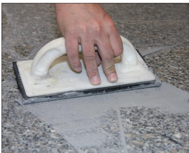
**5** Jointoiement de la surface des pierres naturelles avec un Joint Sopro (p.ex. Joint Sopro Brillant®).
