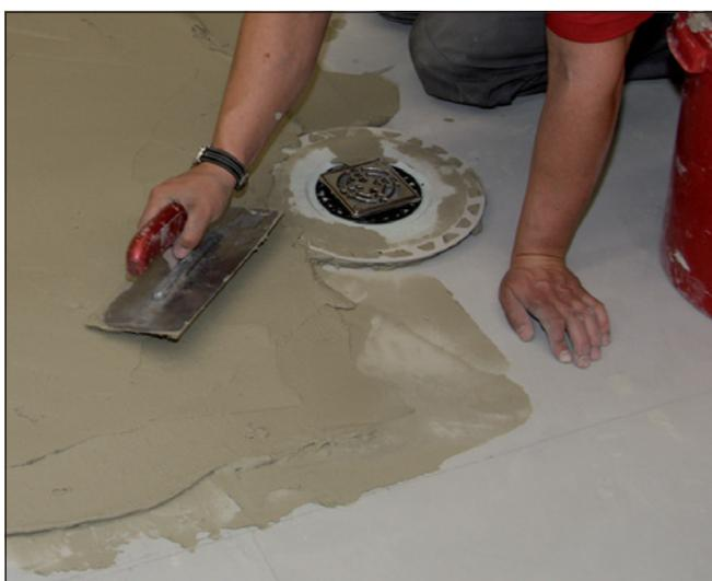
**3** ... puis lisser à la règle l'inclinaison réalisée en épaisseur maximale de 10 mm avant appliquer l'imperméabilisation adhérente.
