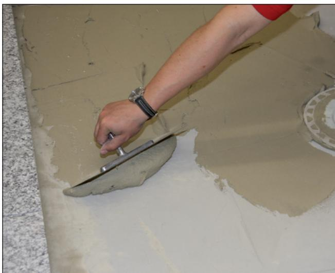
**1** Pour la réalisation d'un ragréage incliné sur des surfaces limitées, appliquer tout d'abord une couche de contact avec la Colle Sopro FKM XL.
