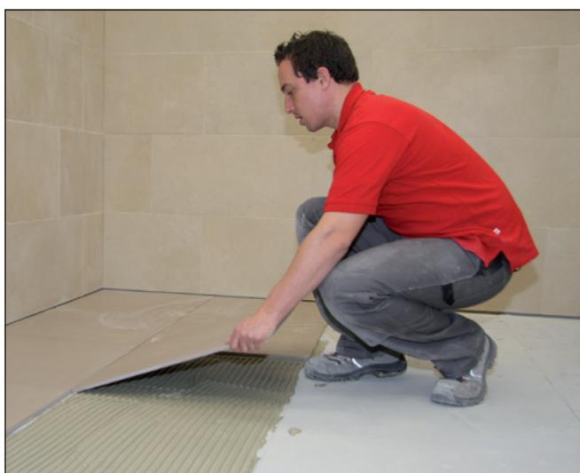
**3** Afficher les carreaux de GPV de grand format en exerçant une pression puis ajuster. Avant durcissement, gratter les joints.
