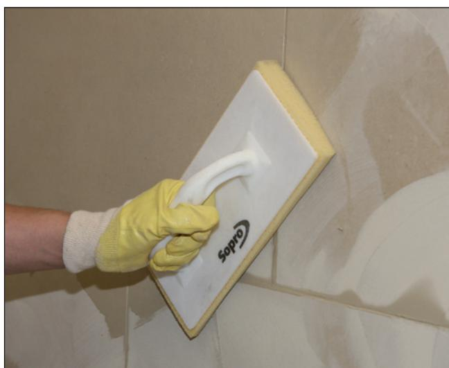
**4** Nettoyage des carreaux après prise suffisante du Joint Sopro appliqué.
