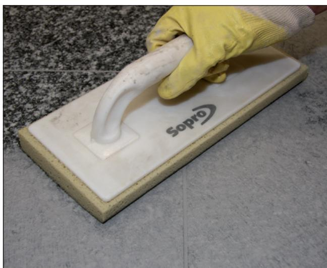
**6** Nettoyage des dalles après prise suffisante du Joint Sopro appliqué.
